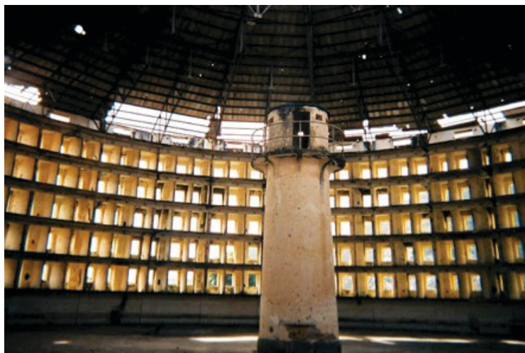
Interior do que restou de um dos prédios do Presídio Modelo em Cuba
